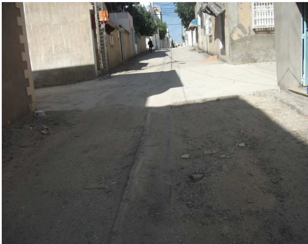
Figure 10: Etat de la rue de Sousse qui en cour de réhabilitation.
