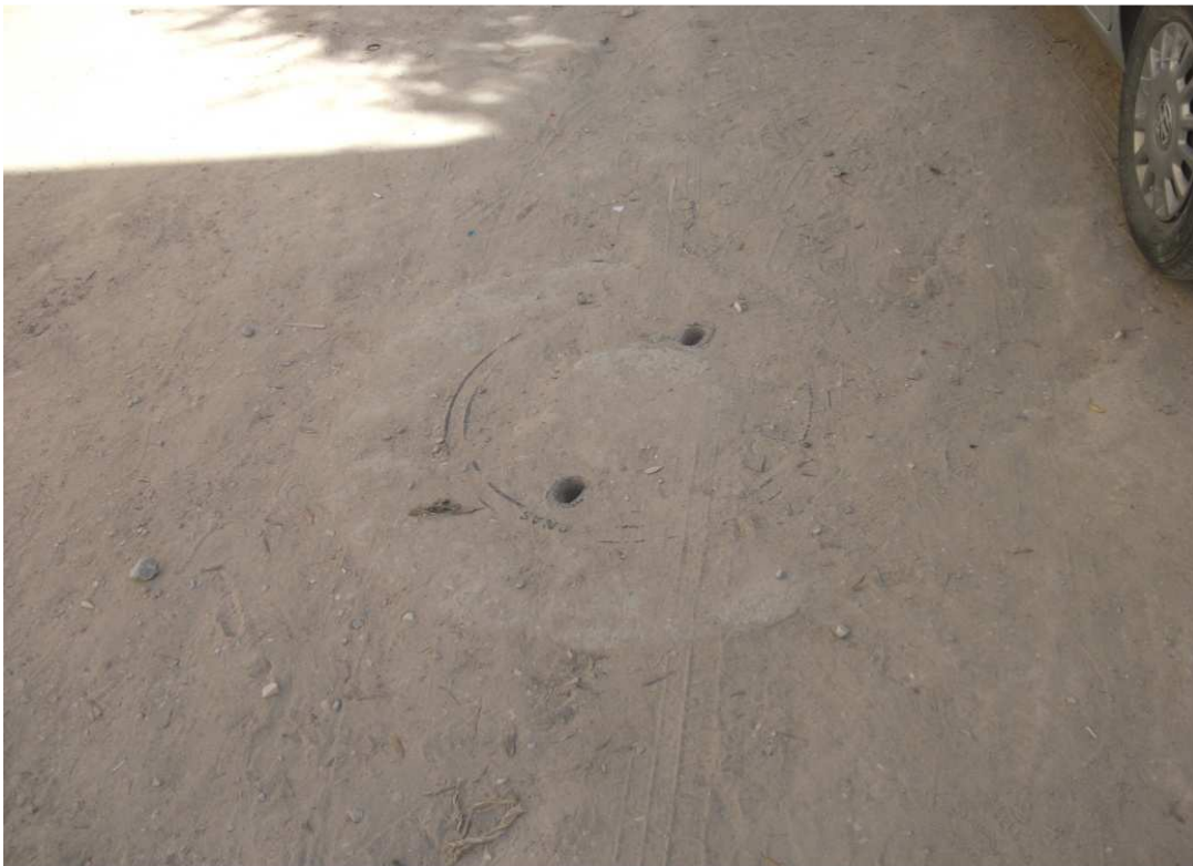
Figure 9: Tous les logements de l'impasse sont desservis par un réseau d'assainissement des eaux usées en bon état de fonctionnement. Implanté au milieu de l'impasse ce qui va compliquer l'exécution du réseau de drainage.
